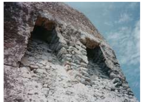
Fig.3.12 - Troniere del lato di costa Sud Est.
