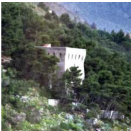
Figg.3.43 - Veduta della torre dal mare.
