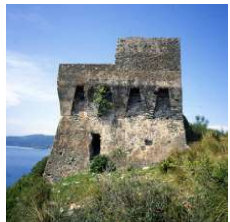
Fig.3.4 - Ingresso all'unico piano della torre sul lato di costa Sud-Est.
