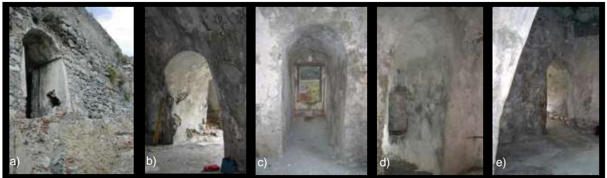
Fig.3.75 - Terzo livello: a) accesso; b) accesso visto dall'interno; c) apertura che affaccia a Sud; d) - e) ambienti interni.
