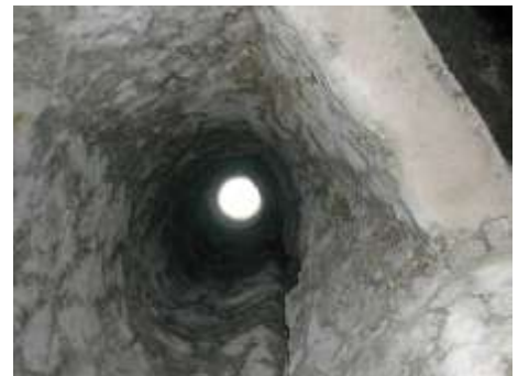
Fig.3.66 - Cavedio per la raccolta delle acque meteoriche visto dal basso (secondo livello) verso l'alto. Esso collegava direttamente la piazza con la cisterna della torre; i piani abitabili erano dotati di un'apertura su di esso necessaria all'adduzione dell'acqua.
