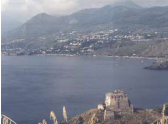
Fig.3.58 - Veduta della torre da monte.
