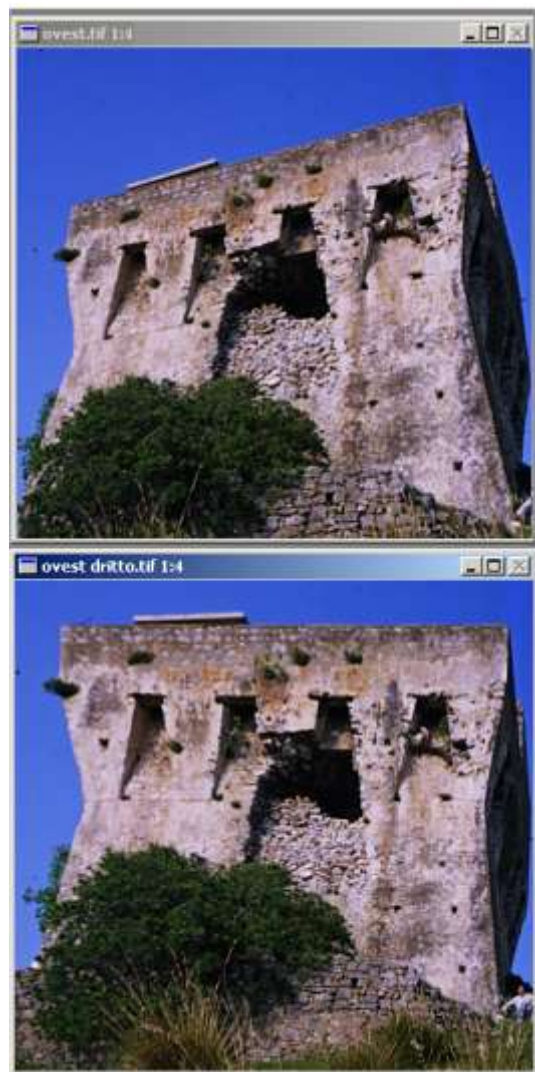
Fig.5.15 - Raffronto diretto tra le immagini del fronte Sud-Ovest della torre, prima e dopo il fotoraddrizzamento.
