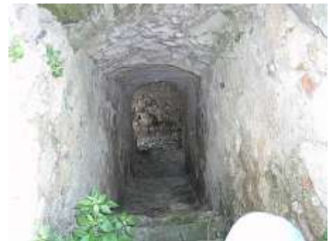
Fig.3.96 - Scale incassate nello spessore murario del lato Nord-Est, destinate al collegamento tra i due livelli, oggi invece a cielo aperto.
