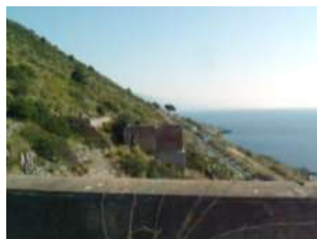
Fig.4.11 - Veduta dalla piazza della T. di Capobianco verso Sud.
