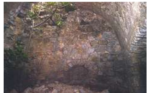
Fig.3.35 - Interno della torre; copertura voltata a botte.
