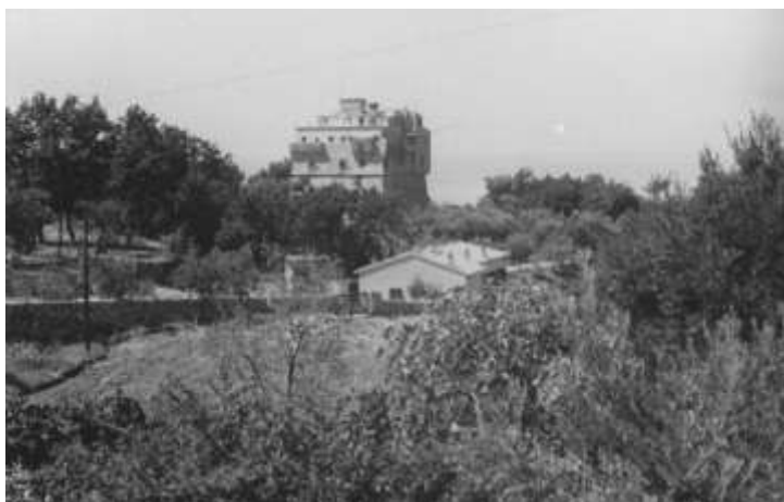
Fig.2.40 - Torre di Santa Venere a Maratea (PZ) nel 1960, dopo il "restauro".
