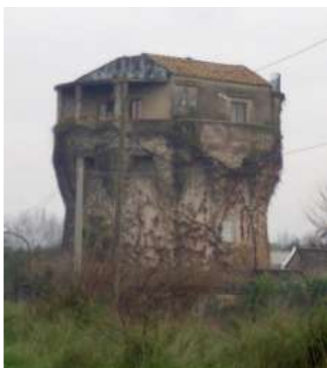
Fig.2.42 - Torre sul Tusciano, località "La Spineta", Battipaglia (SA).
