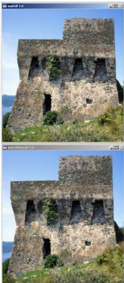
Fig.5.14 - Raffronto diretto tra le immagini del fronte Sud-Est della torre, prima e dopo il fotoraddrizzamento.
