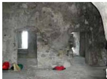
Fig.3.71 - Terzo livello: ambienti del visti dall'ingresso.
