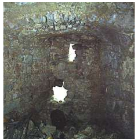
Fig.3.31 - feritoie sul fronte mare.
