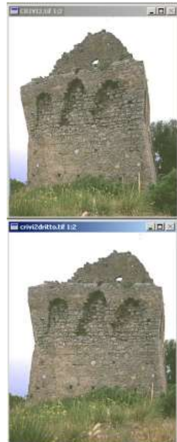
Fig.5.19 - Raffronto diretto tra le immagini del fronte Est della torre, prima e dopo il fotoraddrizzamento.
