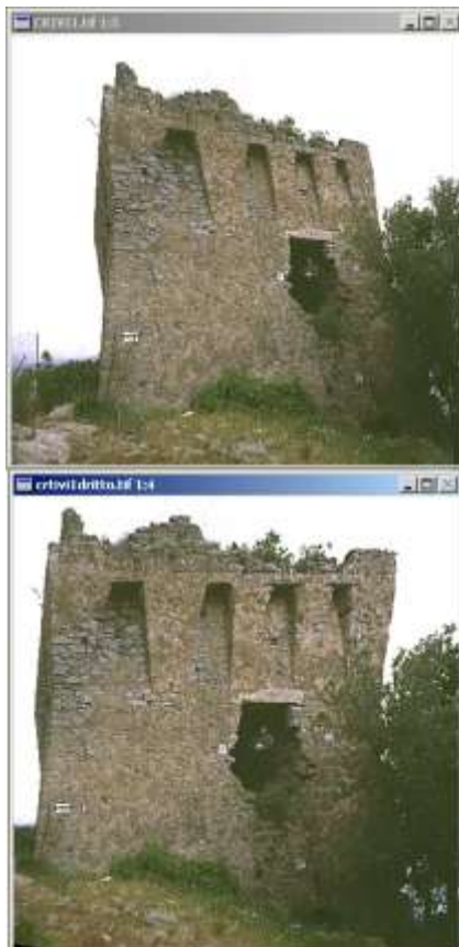
Fig.5.18 - Raffronto diretto tra le immagini del fronte Nord della torre, prima e dopo il fotoraddrizzamento.
