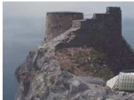
Fig.2.44 - Torre Apprezzami l'Asino: vista dal crinale a monte.
