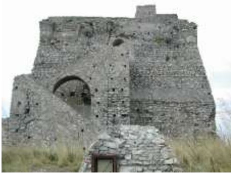
Fig.3.62 - Scala d'accesso sul fronte Est.
