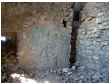
Fig.3.9 - Nicchia di alloggiamento della scala a pioli di collegamento alla piazza.
