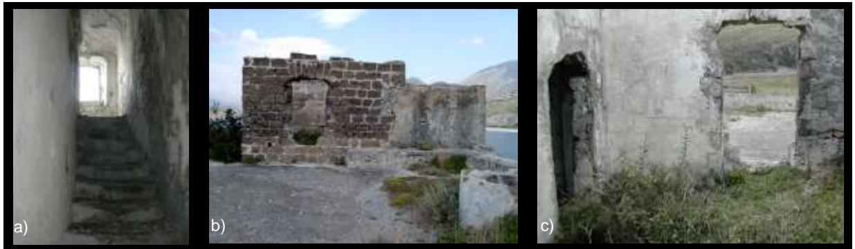
Fig.3.74 - Piazza della torre: a) scala d'accesso dal secondo livello; b) corpo accessorio ed imbocco del cavedio di collegamento alla cisterna; c) corpo accessorio dall'interno.
