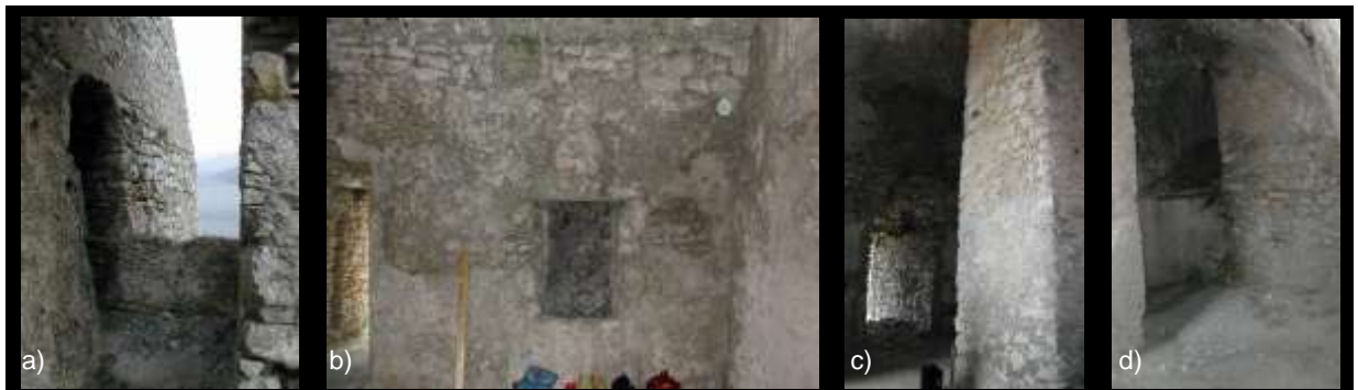
Fig.3.76 - Secondo livello: a) accesso; b) accesso visto dall'interno e apertura sul cavedio per l'adduzione dell'acqua dalla cisterna; c) pilastro centrale di sostegno alla volta; d) apertura strombata, attualmente tamponata, sul lato Nord.
