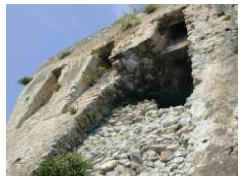
Fig.3.13 - Troniere del lato mare. La grande apertura taglia la troniera centrale.
