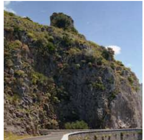
Fig.3.18 - Vista della torre dalla S.S.18 nel senso di percorrenza Nord-Sud.
