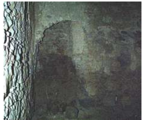
Fig.3.30 - Nicchia di alloggiamento della scala a pioli di collegamento alla piazza.
