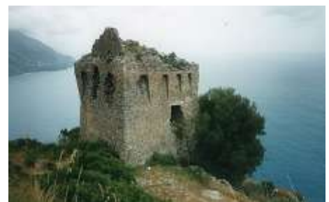
Fig.3.19 - Vista della torre da monte.
