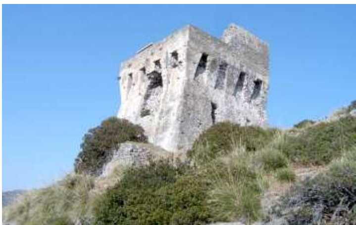
Fig.3.3 - Vista Sud ripresa dal ripido sentiero d'accesso alla torre.
