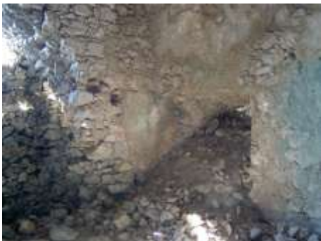
Fig.3.8 - Spigolo compreso tra la grande apertura sul lato mare e la feritoria sul lato di costa Nord-Ovest.
