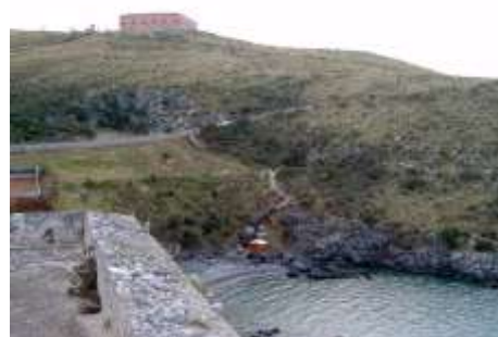
Fig.4.65 - Il Palazzo del Principe visto dalla piazza della T. di San Nicola Arcella.
