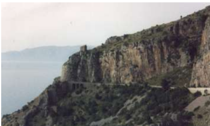
Fig.3.20 - Vista della torre dalla S.S.18 nel senso di percorrenza Sud-Nord.
