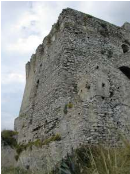
Fig.3.64 - Vista dello spigolo Sud-Est dal basso. E' percepibile l'imponenza della torre
