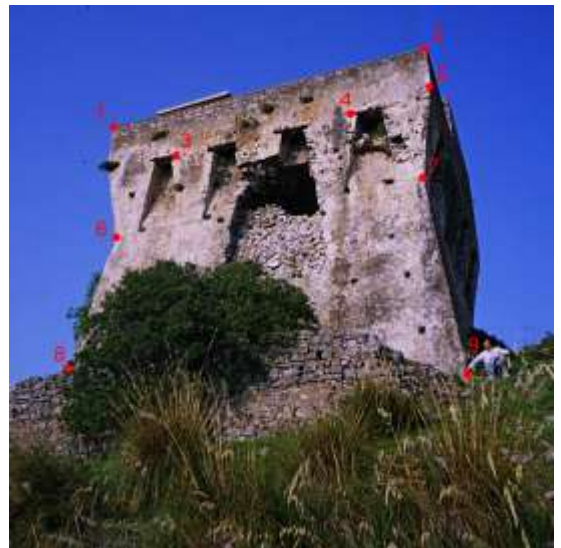
Fig.5.7 - Individuazione dei punti caratteristici sull'immagine fotografica del fronte Sud-Ovest.
