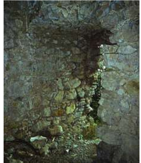
Fig.3.29 - Accesso alla torre.
