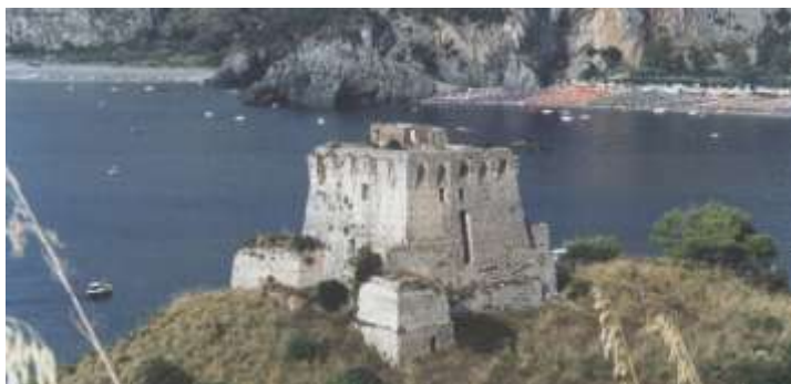
Fig.3.57 - La torre vista dalla pendente strada di scesa al mare. Sono visibili i due speroni artificiali destinati al ricovero dei cavalli.
