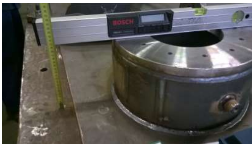
Slika 4.70: Kontrola visine kupola s prirubnicom visoko naponske strane
