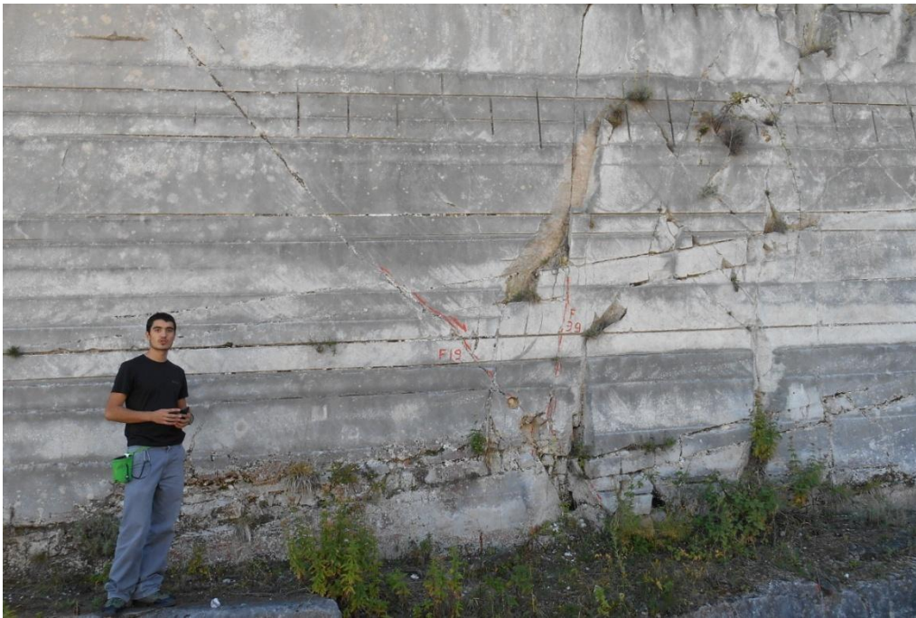
Figura 86 – Scan line 1 presso la cava di Madonna della Mazza; si possono vedere alcune delle faglie presenti sulla parete.
