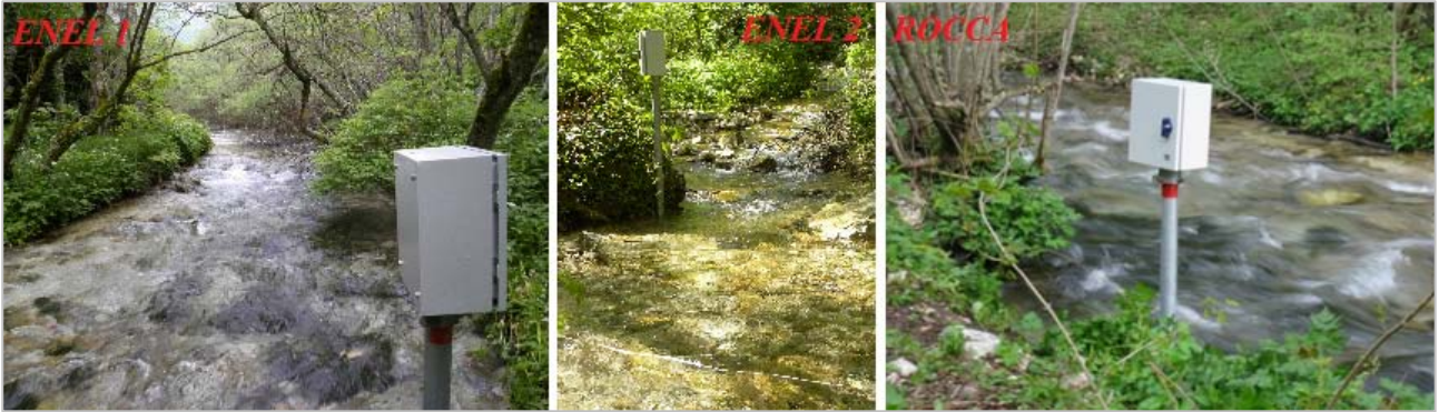
Figura 4.12 – Centraline per il monitoraggio in continuo del livello idrometrico, della conducibilità e della temperatura.
