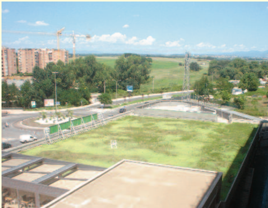
Fig. 7. Copertura verde per il corpo di fabbrica a destinazione d'uso commerciale, per complessivi 1700 mq. circa (ImpreMe Spa; 2012)
