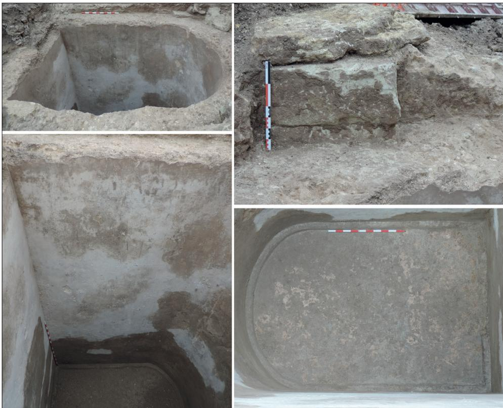
FIGURA 3. CISTERNA EXCAVADA EN LA CALLE RAFAEL DE LARA. ARRIBA: A LA IZQUIERDA VISTA GENERAL DE LA ESTRUCTURA Y A LA DERECHA DETALLE DE LAS LAJAS DE CALCARENITA APOYADAS SOBRE SILLARES QUE FORMARÍAN LA CUBRICIÓN. ABAJO: VISTAS DEL INTERIOR DE LA CISTERNA; A LA IZQUIERDA SE APRECIA LA PROFUNDIDAD Y A LA DERECHA EL FONDO DE LA MISMA
