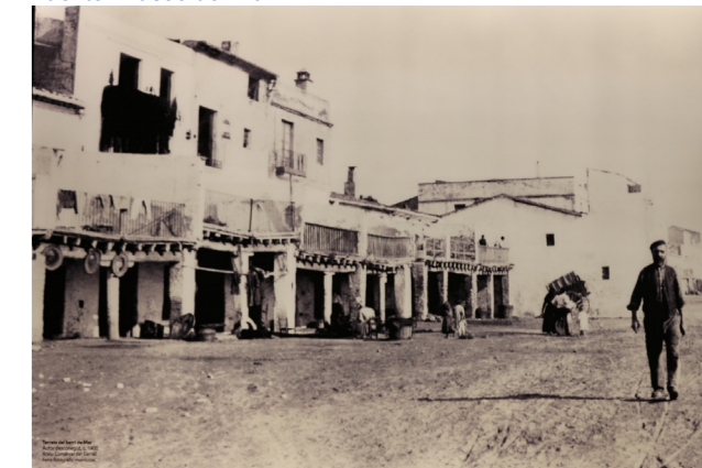
[14] Terrados del barrio del Mar Fuente: ACGAF.060-001 Ayuntamiento Vilanova i la Geltrú
