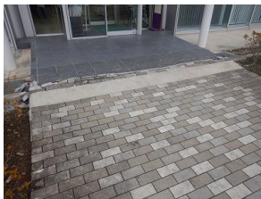
写真11 舗装の被害
