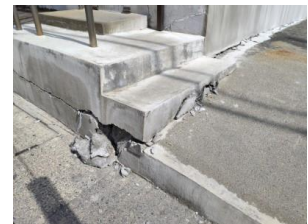
写真 24 基礎の被害
