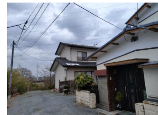
写真 60 瓦屋根の被害
