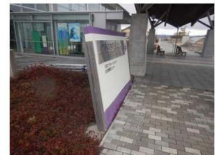
写真12 掲示板の 被害
