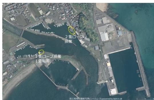
図-8 佐賀漁港における被害箇所
