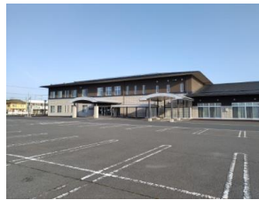
写真1 栗原市築館 総合支所
