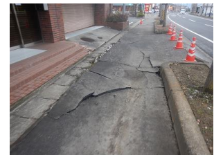
写真8 舗装の被害
