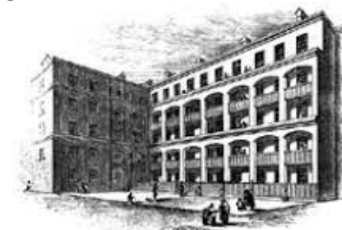
Imagen 03 Vista exterior del "Lofty pile".
