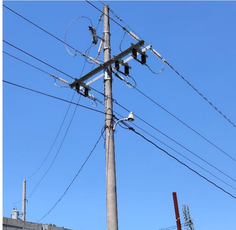
Figura 11. Cuchillas seccionadoras
