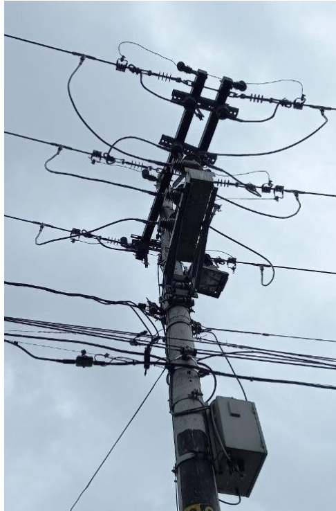
Figura 12. Seccionador automatizado
