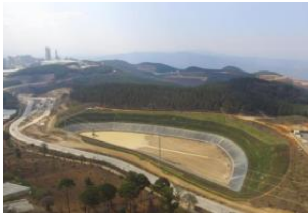
Figura 7. Reservorio Planta San Gabriel (después)
