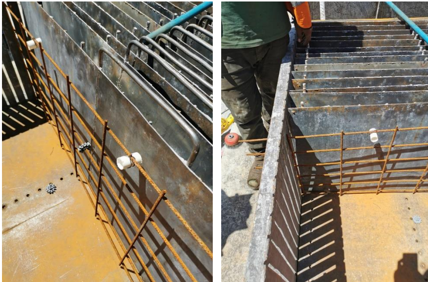
Figura 23. Colocación de malla electrosoldada
