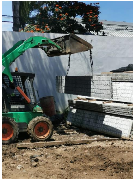
Figura 26. Transporte de losas prefabricadas in situ
