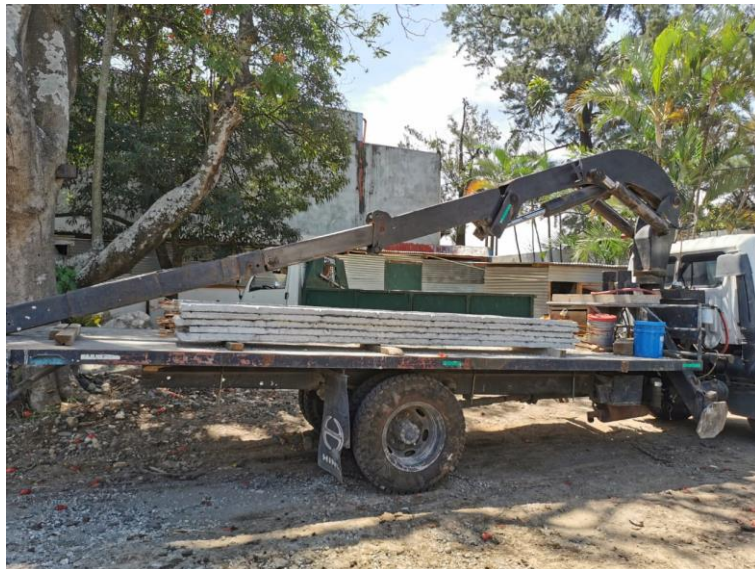
Figura 27. Transporte de losas prefabricadas in situ con camión grúa
