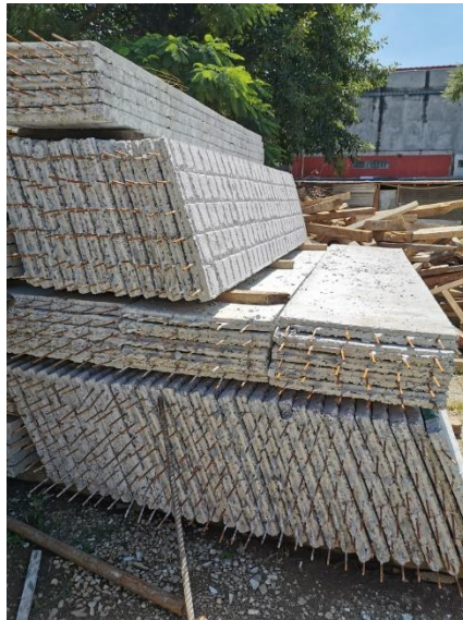
Figura 28. Almacenamiento de losas prefabricadas in situ
