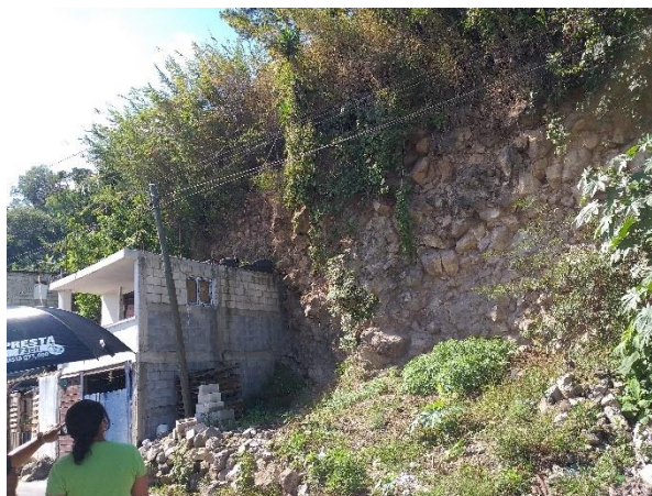
Figura 120. Viviendas bajo barrancos
