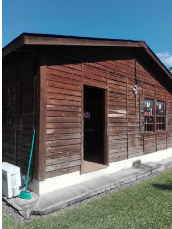
Figura 135. Casa en buen estado
