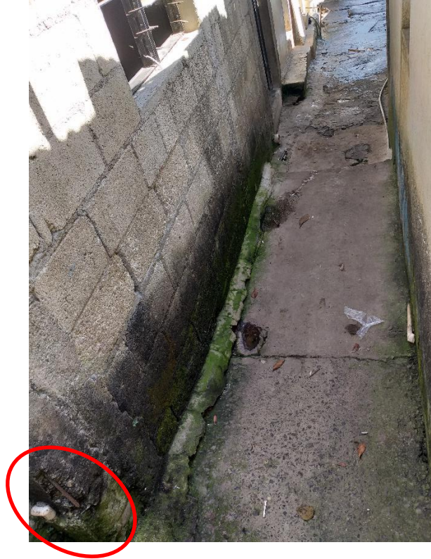
Figura 127. Muro húmedo
