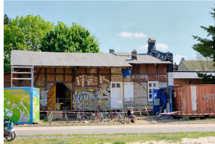
Die ehemaligen Gepäckabfertigung wird in ehrenamtlicher Arbeit saniert und beherbergt künftig die Utopiawerkstadt
