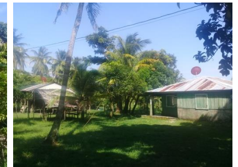
Imagen 3-26: viviendas en condición media de habitabilidad. Fuente: Br. Mariana Manzanarez.
