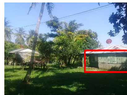
Imagen 3-36: cerramiento combinado de madera machimbrada y concreto ubicado en Comunidad de Awas. Fuente: Br. Mariana Manzanarez
