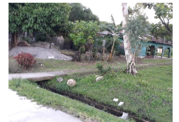
Imagen 3-3: drenaje pluvial calle principal del municipio. Fuente: Br. Mariana Manzanarez.
