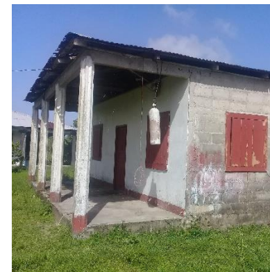
Imagen 3-37: ventanas y puertas de vivienda ubicado en Comunidad de Awas. Fuente: Br. Mariana Manzanarez
