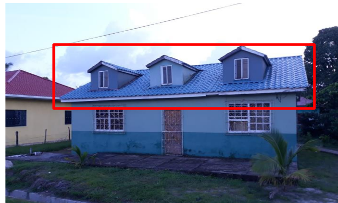
Imagen 3-33: inclinación de cubierta abohardillada ubicado en Laguna de Perlas. Fuente: Br. Mariana Manzanarez
