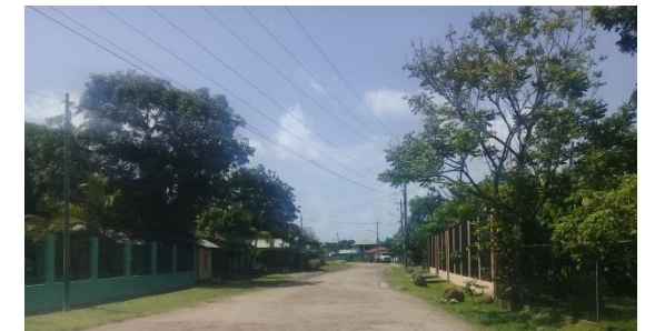
Imagen 3-2: cables de energía eléctrica en calles de Laguna de Perlas. Fuente: Br. Mariana Manzanarez.
