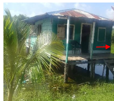
Imagen 3-35: cerramiento con madera machimbrada horizontal ubicado en Comunidad de Awas. Fuente: Br. Mariana Manzanarez
