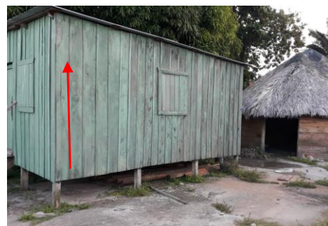
Imagen 3-34: cerramiento con madera machimbrada vertical ubicada en Laguna de Perlas. Fuente: Br. Mariana Manzanarez
