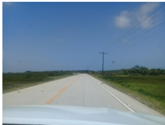
Imagen 3-5: tramo de carretera terminada cercana al municipio. Fuente: Br. Mariana Manzanarez
