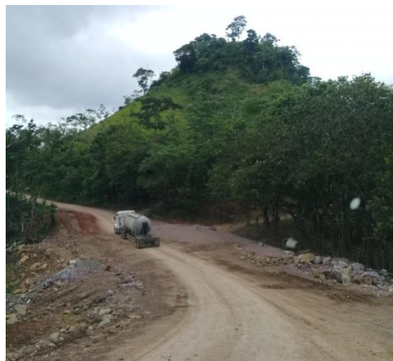
Imagen 3-4: tramo en construcción carret. Rama-Laguna de Perlas. Fuente: Br. Mariana Manzanarez.
