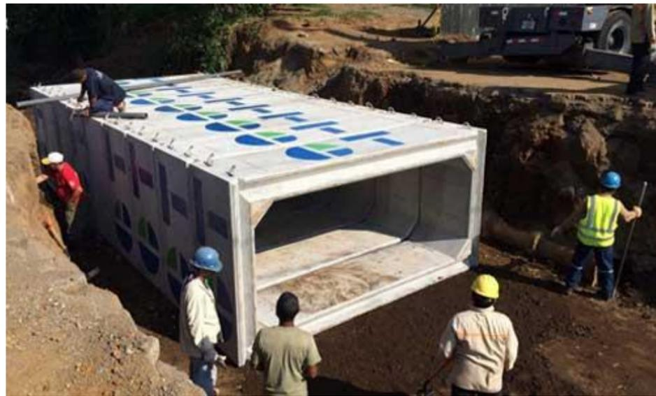
Imagen 81 caja Puente. Proceso de Instalación Fuente: Concretera Total
