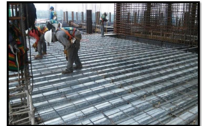
Ilustración 46 detalle de armado losacero, fuente: Google imágenes
