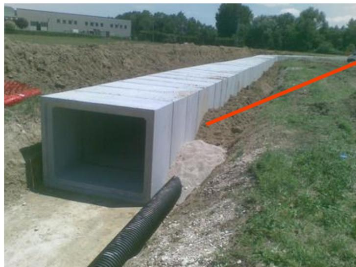
Imagen 82 Colocación de Caja Puente. Fuente; Concretera Total
