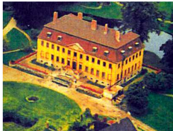
Abbildung 147: Heizprovisorium nördlich des Schlosses (rechts im Bild als weißer Quader). Foto: unbekannter Autor. Slg. Jens Möbert.
