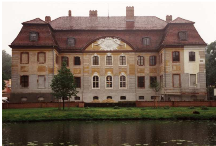
Abbildung 189: Die Schlosshülle während der Wiederherstellungsarbeiten mit Resten der letzten Farbfassung, Putzerneuerungen und einer Stuckrekonstruktion im Mittelrisalit. Foto: Edgar Giegold, 1994. Slg. SFP, Fotothek, o. Sign.
