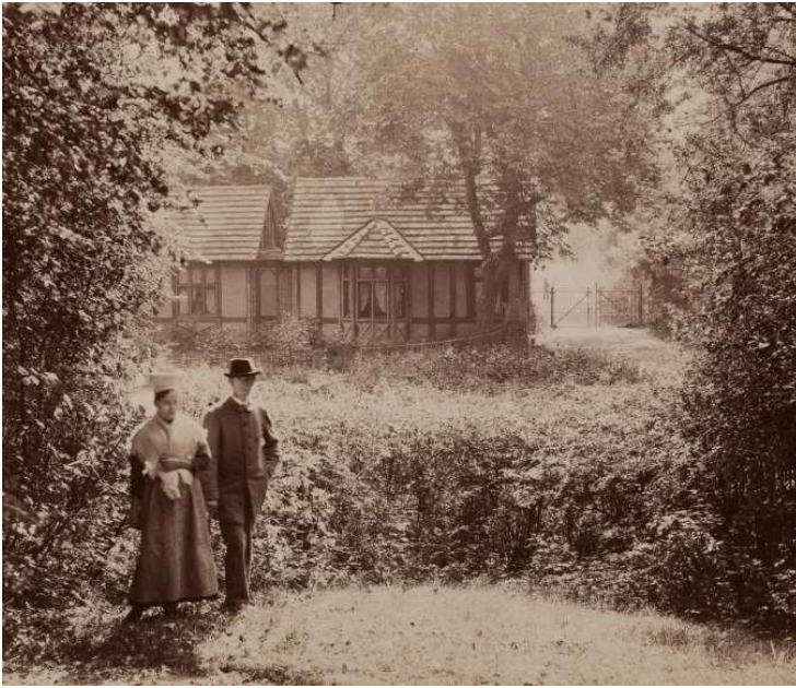
Abbildung 53: Im Jahr 1888 erfolgte unter Heinrich von Pückler der Neubau des Branitzer Torhauses in Fachwerkkoptik. 392 Foto: Carl Metzner, um 1890. Slg. SFP, o. Sign.
