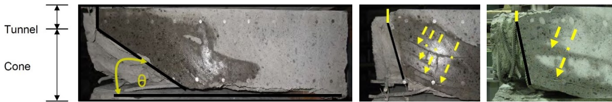
Bild 6 Stanzwinkel \theta = 34^\circ – ohne Bügel (links), \theta = 75^\circ – 1,4 % Schubbewehrungsgrad (Doppelkopfbolzen, Mitte), \theta = 78^\circ – 1,4 % Schubbewehrungsgrad (geschlossene Bügel, rechts). Fotos: N. Orbovic [4]
