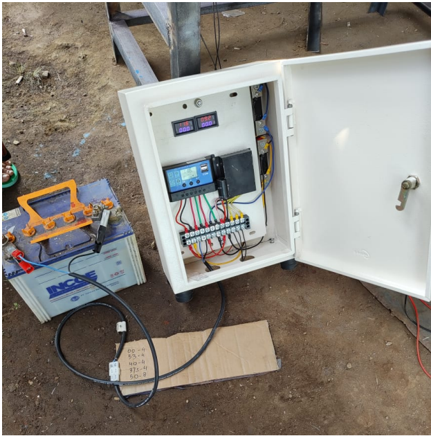
Gambar 4. Perakitan Kontrol Panel dan Baterai Penyimpanan Daya Listrik
