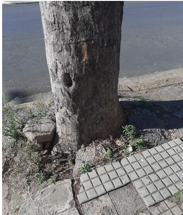
Figura 5. Estrangulamento de base, estouro da calçada e impedimento da infiltração de água no solo na região central de Cabo Verde – MG Figure 5. Base strangulation, sidewalk burst and impediment of water infiltration into the soil in the central region of Cabo Verde - MG
