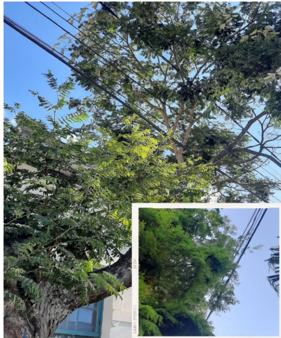
Figura 7. Necessidade de poda de manutenção em indivíduos que entram em contato com a fiação elétrica na região central de Cabo Verde – MG
