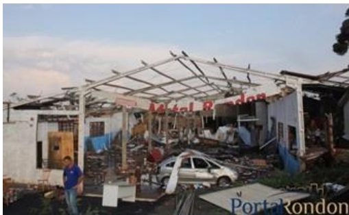
Figura 12: Manutenção da Estrutura de Pré-Moldados
