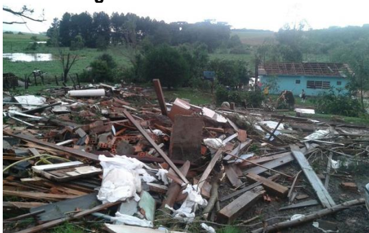
Figura 6: Casa mista destruída
