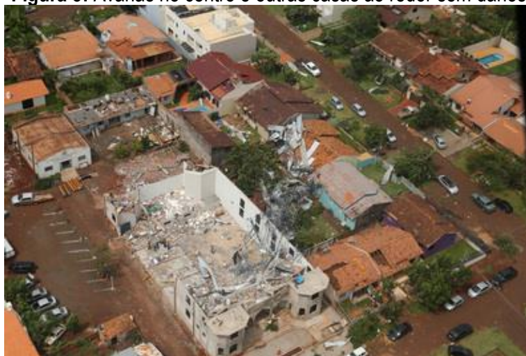
Figura 3: Avarias no centro e outras casas ao redor sem danos
