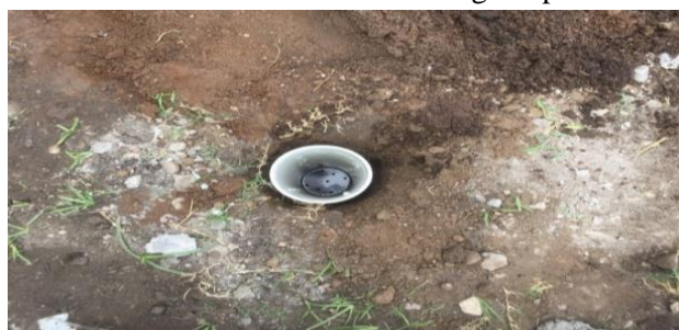
Gambar 5. Pemasangan Pipa Biopori
