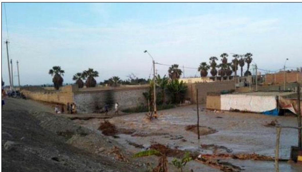
Desborde del río Matagente - Sector Cañapay
