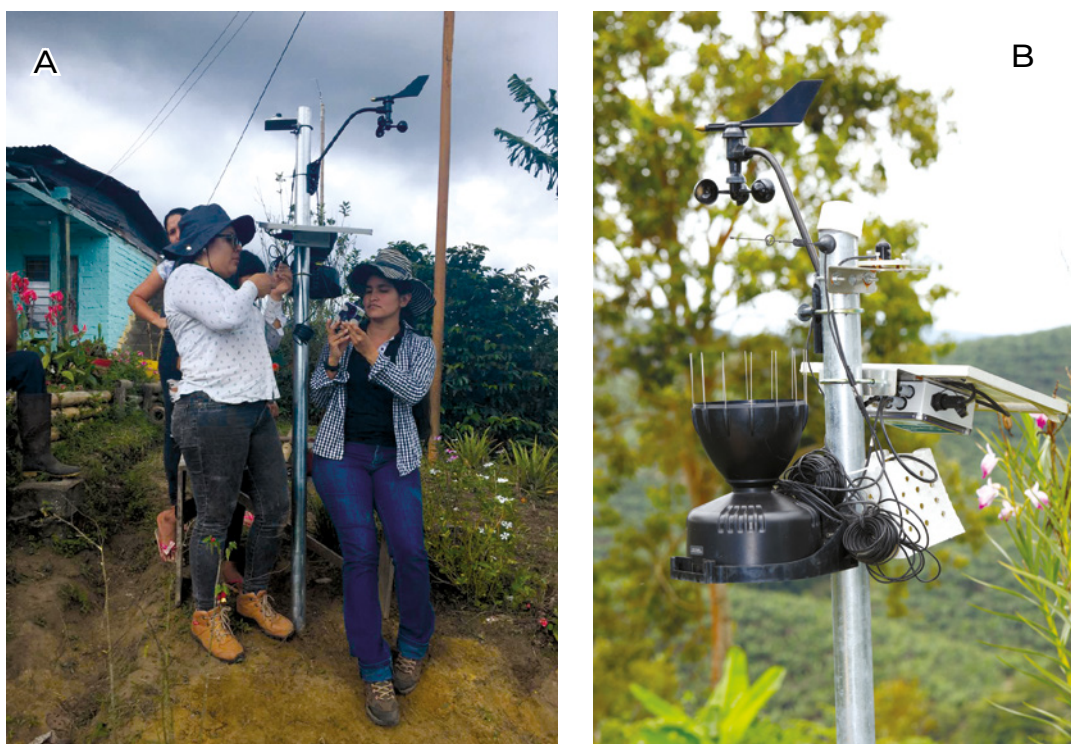
Figura 6. Instalación de la estación meteorológica: A. Instalación de los equipos. B. Estación meteorológica en funcionamiento
