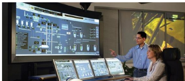
Figura 122. Monitoreo por Scada
