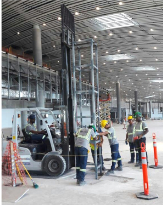
Figura 15. Instalación de pernos de tótems 303 A, B y 324.
