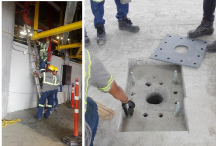
Figura 16. Instalación de pernos y plato de tótems 306 A, B y 234.
