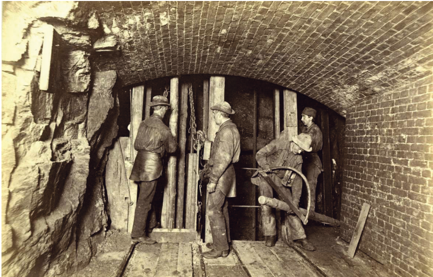
Abb. 9: Langholzhängen an einem Füllort im Abraham Schacht der Freiburger Himmelfahrt Fundgrube (Fotograf: H. Börner, um 1895, Quelle: TU Bergakademie Freiberg/UB)
