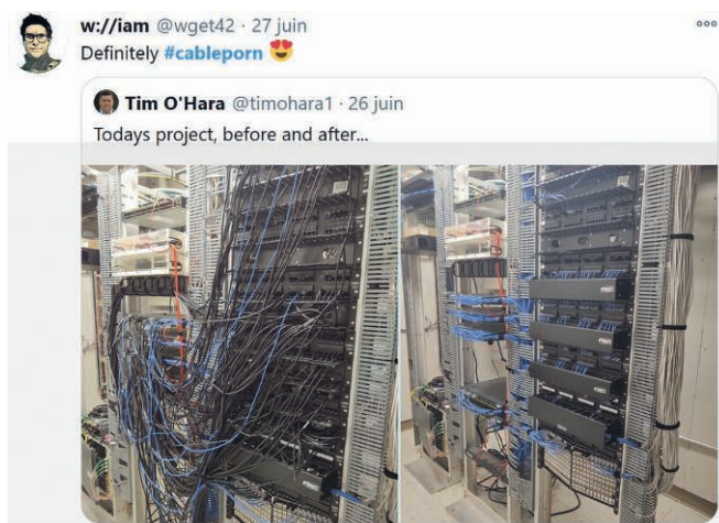
Fig. 2. – Travail de réorganisation du câblage
