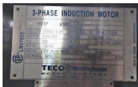
Gambar 3. 2 Name plate motor induksi
