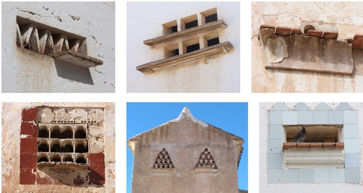
Figura 15. Piqueras de varios palomares en la provincia de Albacete (F. Castilla)
