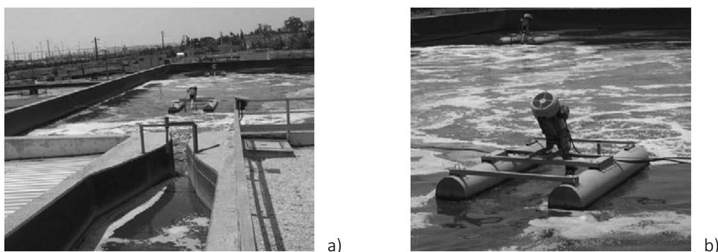
As bacias de equalização com diques de terra compactada e camada impermeabilizante têm custos menores que os tanques de betão. Geralmente, a inclinação dos taludes dessas bacias varia entre 3:1 a 2:1 (h:v).
