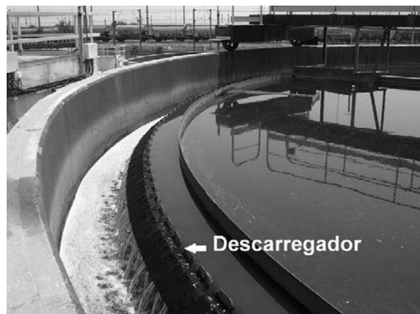
Os descarregadores em forma de “V” (Figura 11.11) são preferíveis aos retangulares, os quais são sujeitos a descarga irregular se não forem per-
