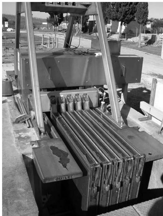
**Figura 19.7** Configuração de reatores de UV: a) com lâmpadas perpendiculares ao escoamento; b) com lâmpadas paralelas ao escoamento; c) em canal fechado e d) em canal aberto
