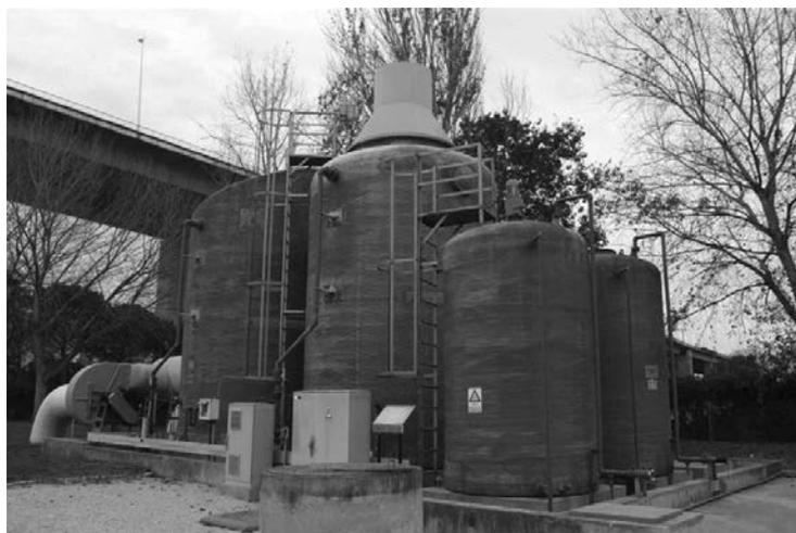
Os silos de armazenamento de SQ sólidas podem apresentar várias formas, mas recomendam-se os silos cilíndricos (Figura 20.5 b)) para evitar os “cantos mortos” e fundo muito inclinado, da ordem do  $60^\circ$ , em cone invertido (Davis, 2010). Para a preparação de soluções as SQ sólidas são retiradas do silo por gravidade ou por sistemas pneumáticos.
