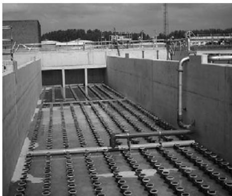
Nos reatores de lamas ativadas também são utilizados painéis retangulares com película de poliuretano flexível perfurada (Figura 13.8). Geralmente os painéis são constituídos por um quadro em aço inox e são colocados no fundo do tanque ou perto deste. No Quadro 13.3 são apresentadas vantagens e desvantagens dos painéis.
