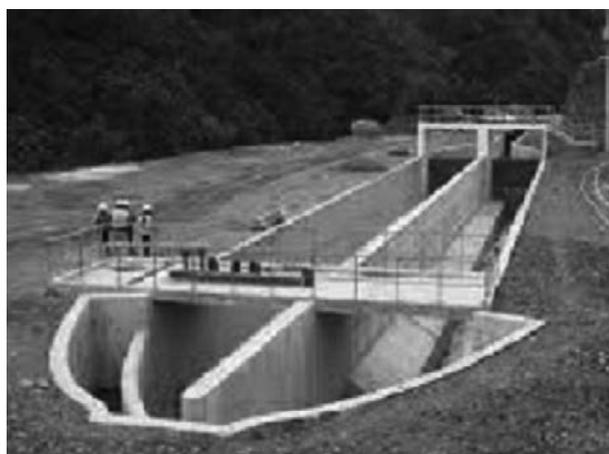
O descarregador Sutor caracteriza-se por a sua curva de vazão ser traduzida por uma equação linear, o que significa que o caudal descarregado varia linearmente com a carga. O perfil do descarregador é definido por uma zona retangular associada a uma zona curva, conforme representado nas Figuras 10.4. e 10.5.
