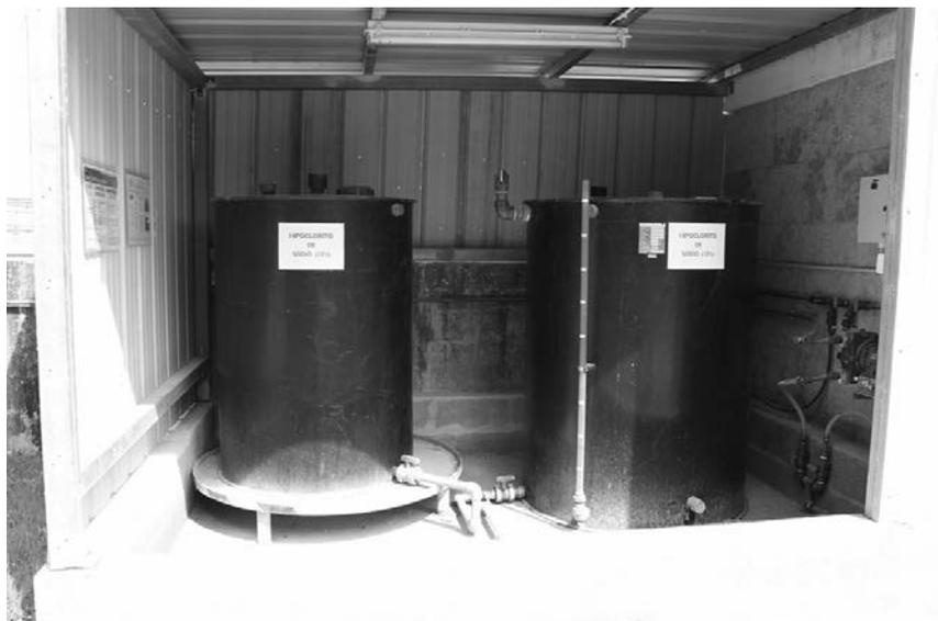
Os reservatórios de armazenamento de SQ no estado líquido devem ser colocados numa bacia de retenção para reter eventuais derrames. A bacia de retenção tem formato retangular ou quadrado, sendo construída em betão com revestimento químico compatível com as SQ a reter.
