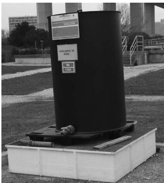
No caso dos reservatórios instalados ao ar livre deve-se ter especial atenção à variação da temperatura ambiente e à concentração da solução. Por exemplo uma solução de sulfato de alumínio comercial a 50,7 % cristaliza a 8,3 °C, enquanto que a solução a 58,8 % cristaliza a -15,6 °C. Em climas extremamente frios pode ser necessário aquecer os reservatórios (Davis, 2010).
