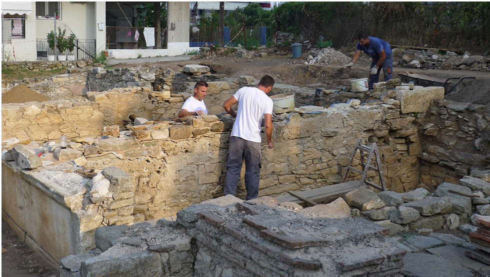
Fig. 17. Les maçons au travail : consolidation du refend MUR196 entre PCE55 et PCE20.
