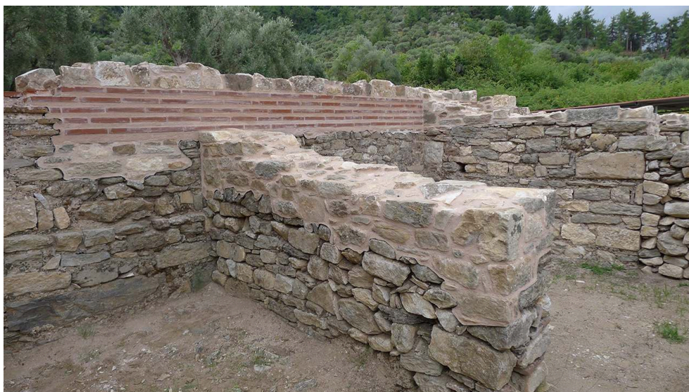
Fig. 20. Le MUR18 avec l'arase de briques reconstruite.
