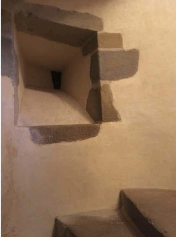
Fig. 2 – La meurtrière du premier état de l'escalier au niveau de la première révolution
