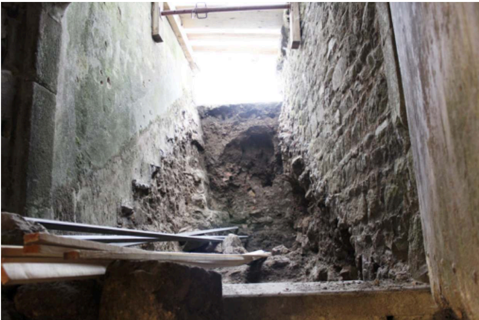
Fig. 3 – Vue de l'entrée du souterrain lors du démontage de l'escalier moderne
