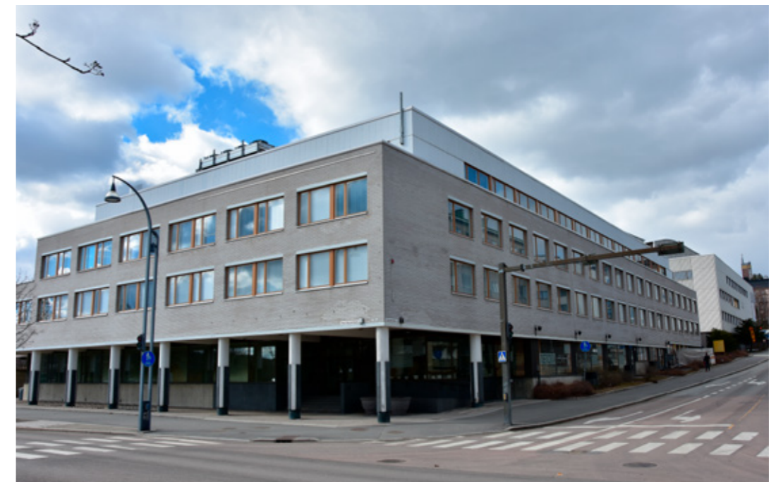
Rakennus c, Poliisitalo (nyk. Tietotalo) Kilpisenkadun ja Hannikaisenkadun risteyksessä.
