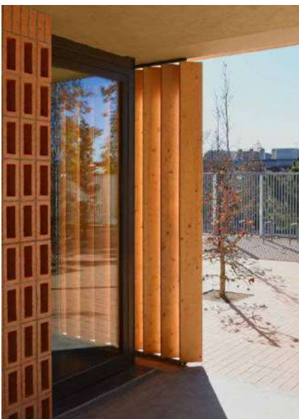
Fig 41. Celosía de lamas móviles de madera. Umbelco, protección solar de edificios.
