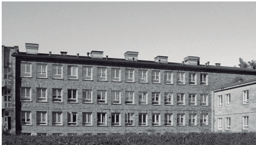
Fig. 6. Fachada trasera del IIA. Fotografía: CSIC.
