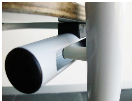
Figura 6.121 – Mecanismo de regulação e ligação entre as estruturas: parafuso cabeça de queijo sextavado interior e espaçador de nylon sem rosca.
