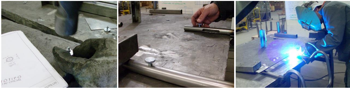
Figura 6.110 – Execução da aplicação do parafuso serrilhado com a porca.
