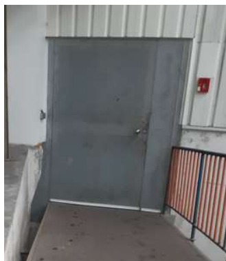
Figura 4.7 - Porta entrada local de risco F
