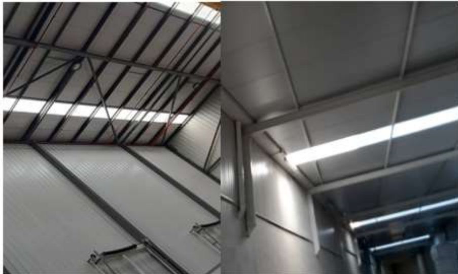
Figura 4.5 - Estruturas metálicas do edifício
