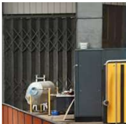
Figura 4.11 - Portão de correr na área técnica do edifício
