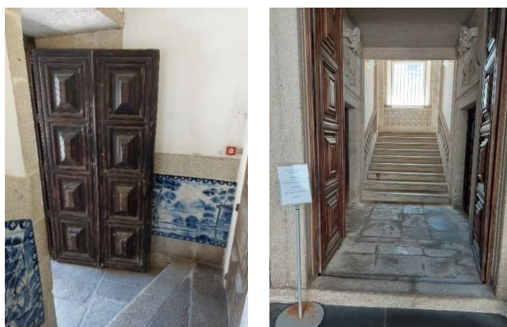
Figura 13 - Vãos interiores em madeira
