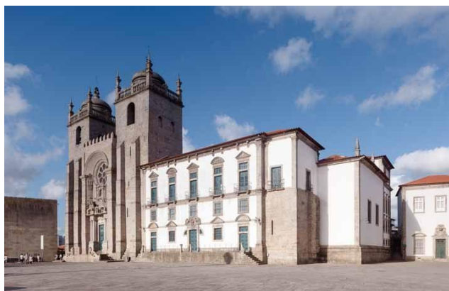
Figura 9 - Acessibilidade às fachadas do edifício
