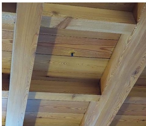
Figura 24 - Detecção por aspiração ou amostragem
