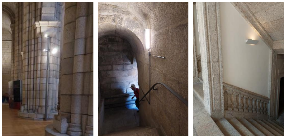
Figura 21 - Iluminação do edifício
