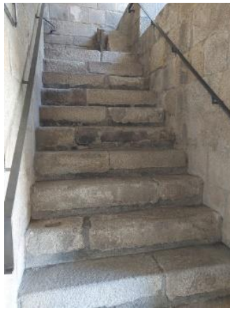
Figura 18 - Escadaria de acesso à torre Norte
