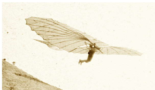
BILD 18. Ein Flug bei geringem Anstellwinkel. Lillenthal begegnet der Gefahr des schnellen Sinkfluges, indem er sein Gewicht stark nach hinten verlagert. Foto: Neuhauss.
