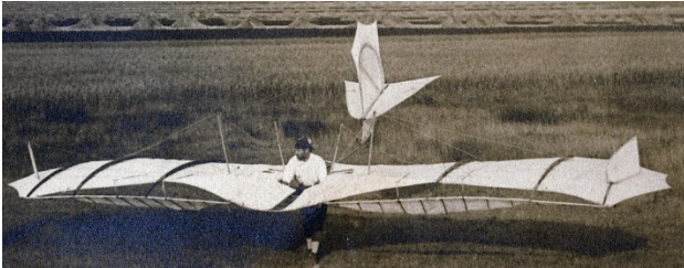
BILD 1. Otto Lilienthal in seinem Experimental-Eindecker mit Flugsteuerung bei Berlin im Jahre 1895 [10].
