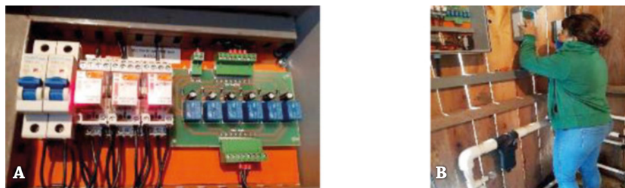
Figura 17. Ajuste del sistema de riego y fertiriego. A) Funcionamiento del mando de arranque y encendido; B) adecuación sistema de riego
