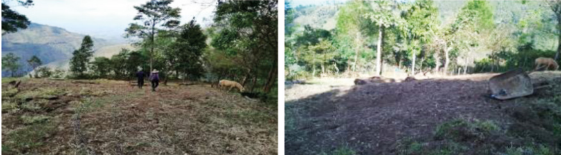
Figura 11. Adecuación previa de los lotes antes de la instalación de los macro túneles Fuente: elaboración propia. Fotografías: H. Vásquez (2019).
