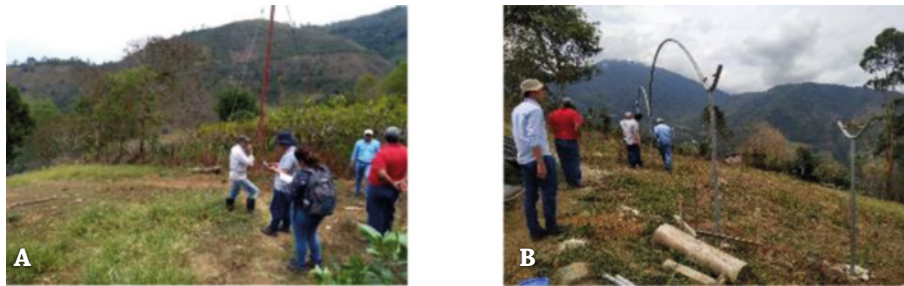
Figura 12. Actividades de planeación y construcción de los macro túneles. A) equipo Scientia y Universidad Nacional de Colombia elaborando ruta de trabajo; B) disposición de las bases para el levantamiento de la estructura Fuente: elaboración propia. Fotografías: O. Gutiérrez (2019).
