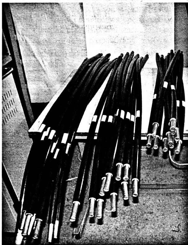
Рис. 4. Опрессовка на провод ППСРМ 1500 кабельных наконечников на МИУ-20
