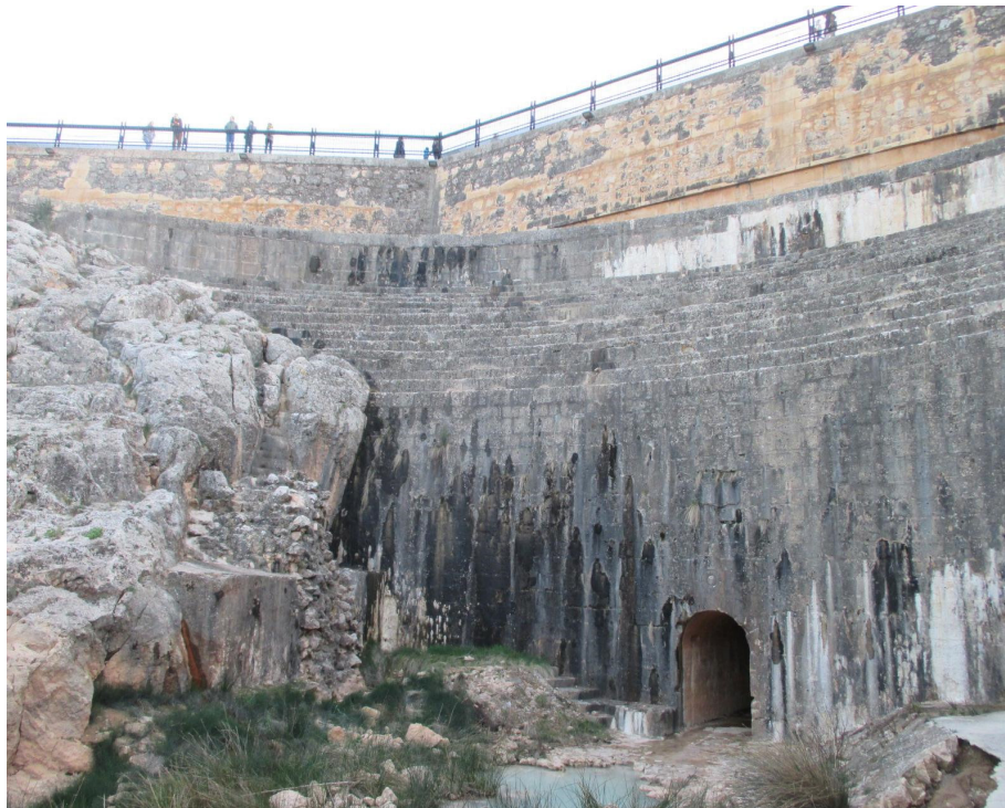
Figura 4. El pantano de Almansa en la actualidad. En la parte superior se puede apreciar el recrecimiento proyectado a finales del siglo XVIII por Bartolomé Rivelles (Elaboración propia)
