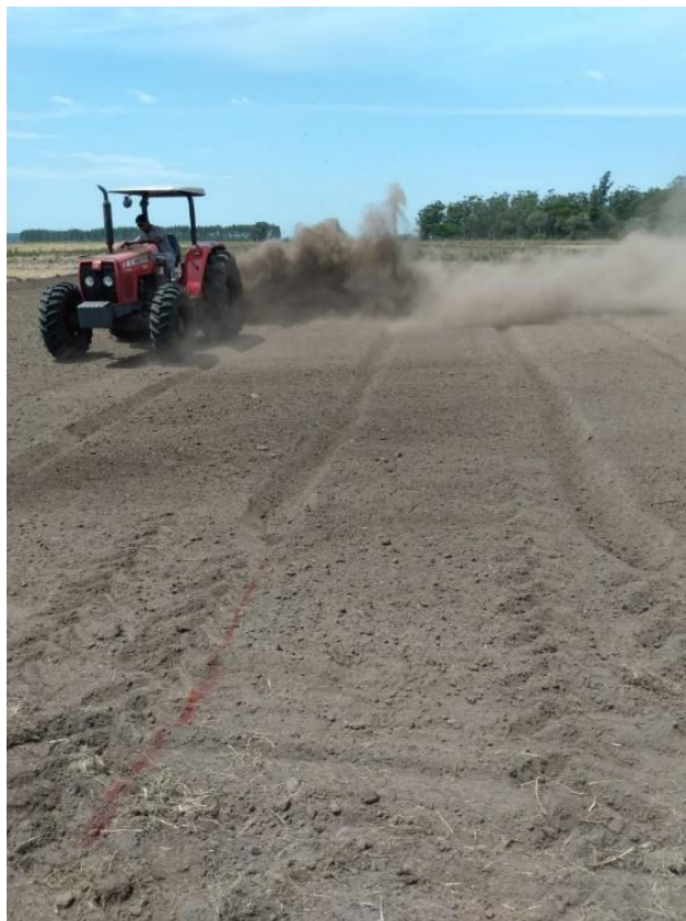
Figura 4: Construção dos Drenos para as Áreas de Soja.
