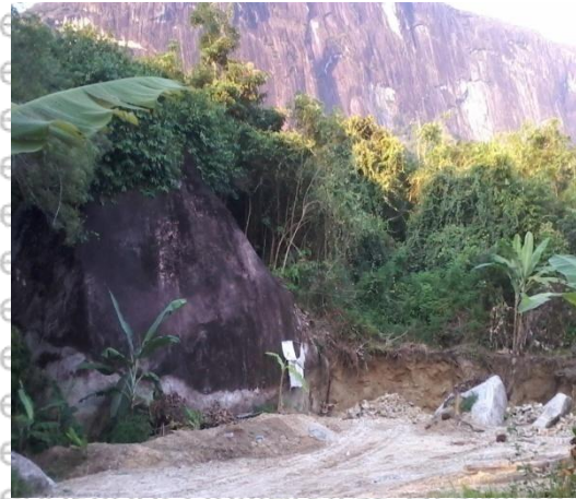
Gambar.5.5. Aktivitas pengalihan dan pemecahan batu dengan cara dibakar pada kawasan TWABK
