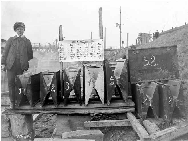
Bild 6 Gelenke der Strombögen vor dem Einbau River arch joints before installation
