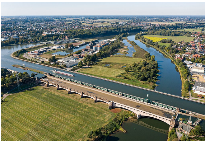
Bild 1 Alte (vorne) und neue (hinten) Kanalbrücke in Minden – die alte Kanalbrücke ist trocken gelegt, Blick in Richtung westliches Widerlager Old (front) and new (back) canal bridges in Minden – the old canal bridge has been drained, and the view is in the direction of the west abutment
