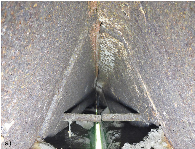
Bild 9 Blick in die Scheitelfuge: a) Gelenkplatten mit verschieden ausgeprägten Korrosionsschäden, b) Bruchstücke einer Gelenkplatte View of the apex joint: a) different degrees of joint corrosion, b) fragments of the joint
