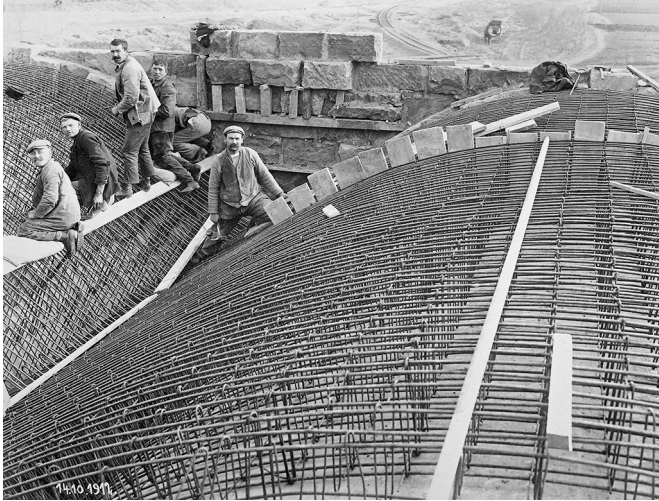
Bild 2 Bau der alten Kanalbrücke: Einbau der Bewehrung der Bögen Construction of the old canal bridge: installing the arch reinforcement
