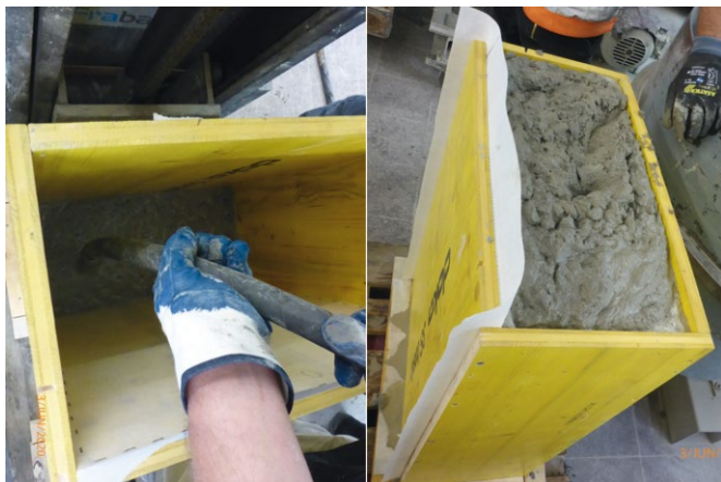
Bild 8 Betonage eines Kleinbauteils zum Nachweis der Wirksamkeit der wasserabführenden Schalungsbahn Construction of a small element to verify the effectiveness of the controlled permeability formwork liners
