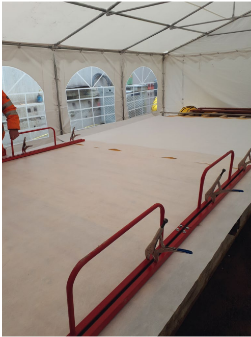
Bild 10 Bespannen der Schalung mit wasserabführender Schalungsbahn Covering the CPF-liners
