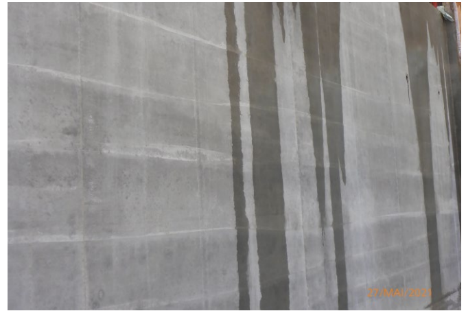
Bild 11 Fertiggestelltes Bauteil mit wasserabführender Schalungsbahn Completed element by the use of CPF-liners
