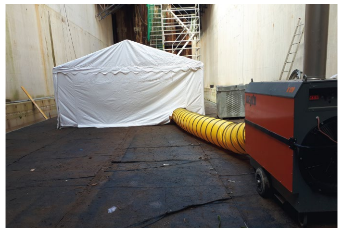
Bild 9 Beheiztes Schutzzelt zum Aufbringen der wasserabführenden Schalungsbahn Heated protective tent for covering the controlled permeability formwork (CPF) liners
