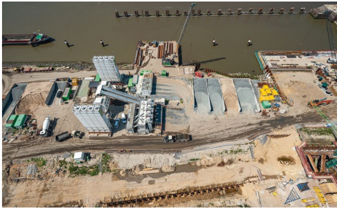
Bild 2 Betonmischwerk und elbseitiger Anleger für Baustofftransporte Concrete mixing plant and feeder
