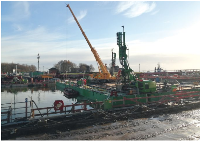
Bild 5 Pontoneinheit mit zwei Bohrgeräten und Mobilkran zur Andienung der Stahlglieder Pontoon unit with two drilling rigs and mobile crane
