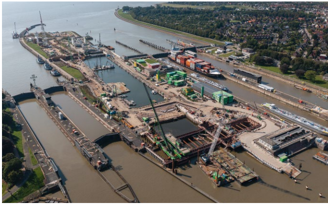
Bild 1 Baustelle der 5. Schleusenammer auf der Schleuseninsel (Jahr 2021) Construction site of the 5 th lock chamber between the existing locks (year 2021)
