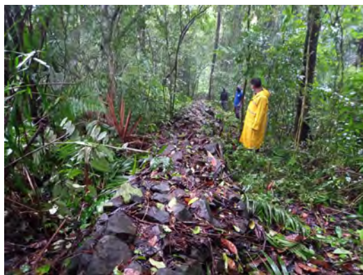
Figura 13. Vista del muro.
