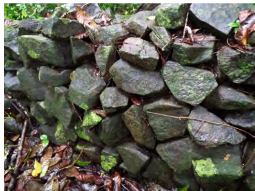
Figura 14. Vista del muro.
