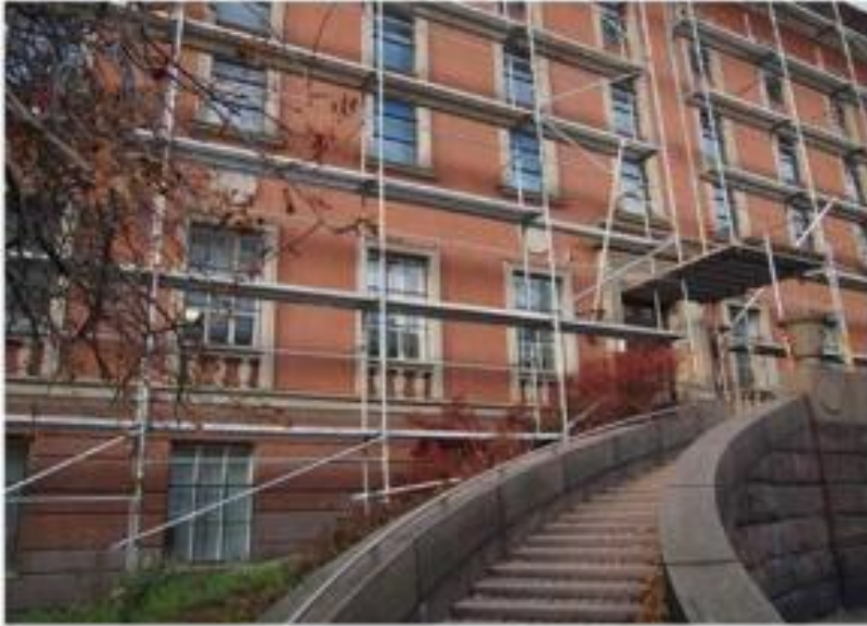
Kuva 9. Turun maakunta-arkiston julkisivu. TMA 29.10.2015 (Eleonoora Vuorela).
