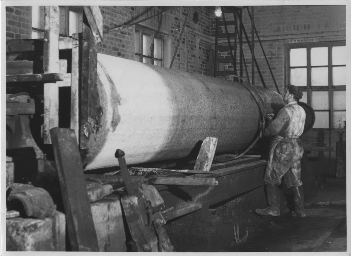
Figur 8. Tillverkning av valsstenar i Salo hos företaget Ab Granit i slutet av 1950-talet. Foto: Samlingen Ab Granit, Åbo Akademis bildsamlingar.
