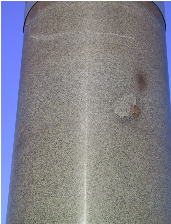
Figur 3. En stor ”stenlapp” i en reparerad stenvals. Sapokka Vattenpark. Kotka, sydöstra Finland. Foto: Olavi Selonen.
